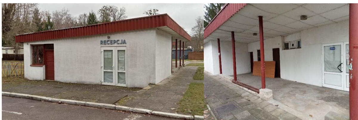
Ryc. 20. Nieużytkowany budynek starej recepcji i stołówki
