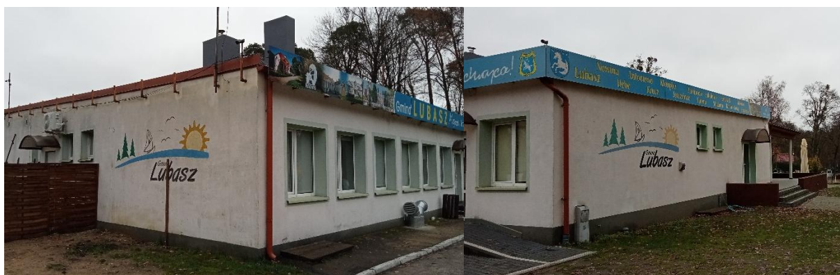
Ryc. 19. Siedziba Gminnego Ośrodka Kultury w Lubasz
