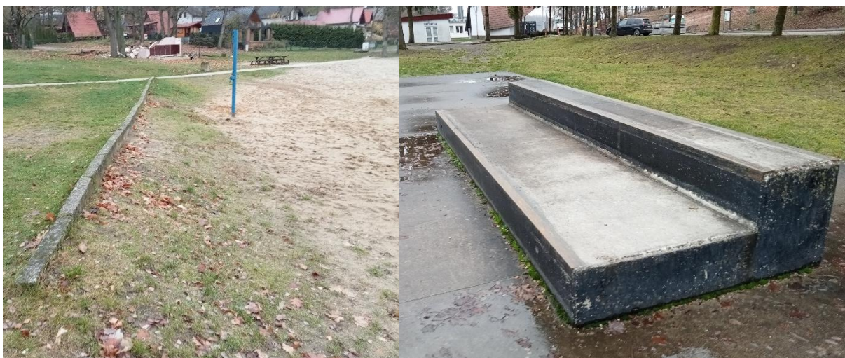
Ryc. 25. Zdegradowane elementy infrastruktury sportowej
